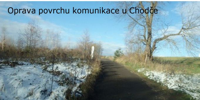
Oprava probořeného kanálu u fontány
