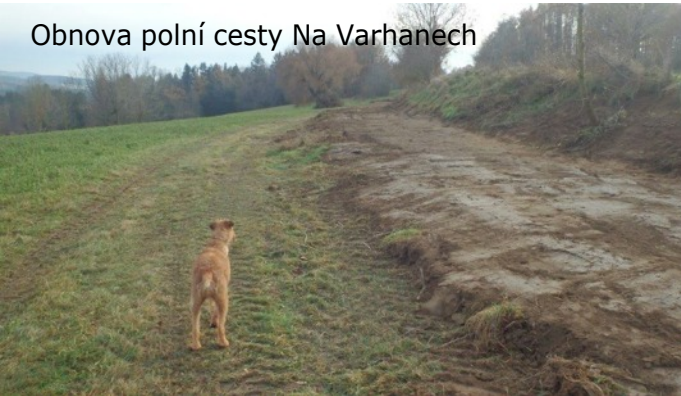
Oprava povrchu komunikace u Chodče
